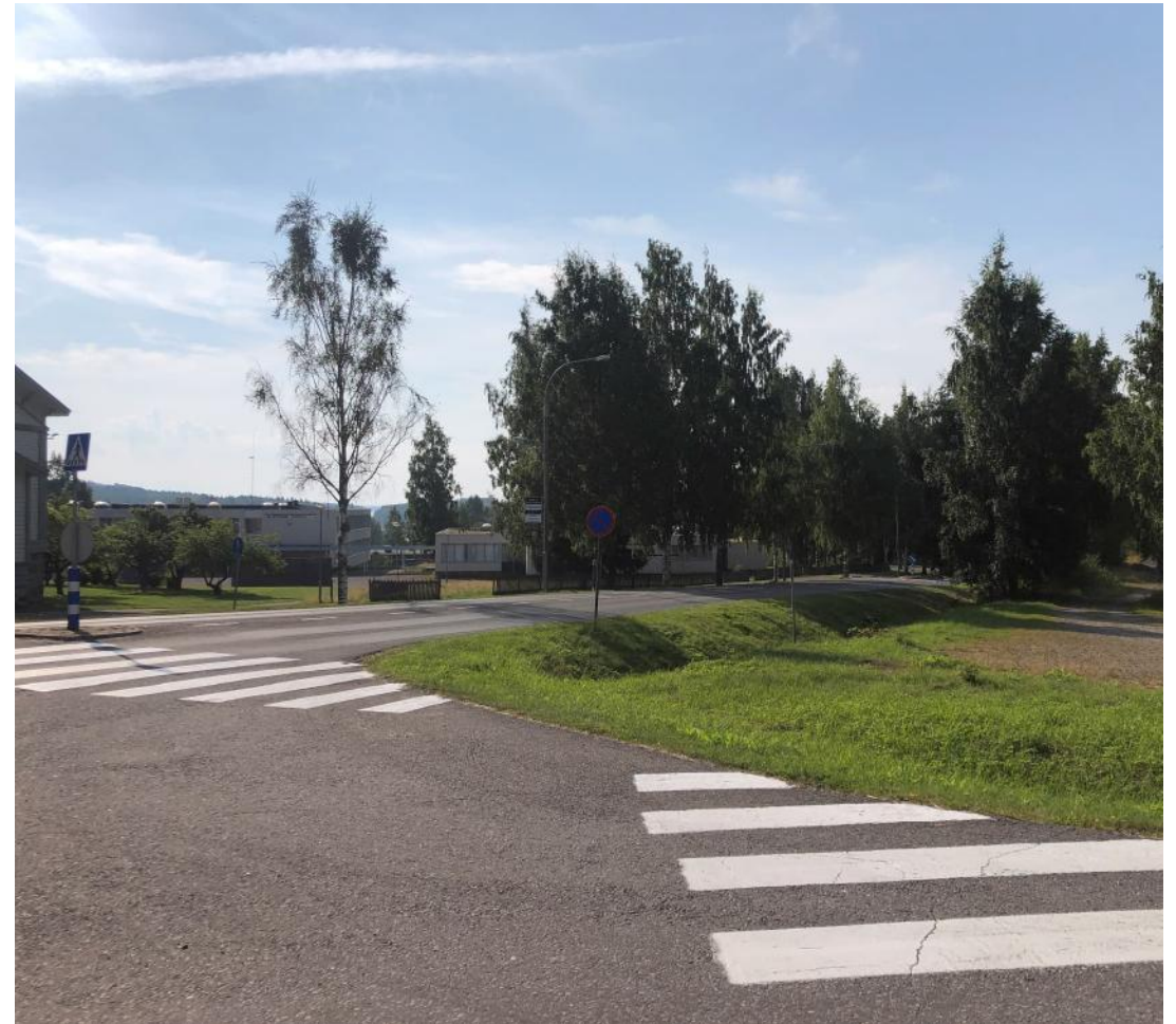
Kuva 35. Leppävirralla (kuten monissa muissakin Kuopion seudun taajamissa) on suojaiteita, jotka liittyvät suoraan sivuojaan tai nurmialueelle. Kuva Leppävirrantieltä (kuva: Sitowise Oy).
