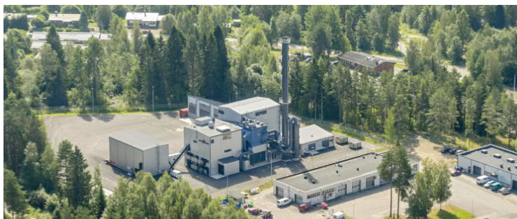
Leppävirran biolämpökeskus, Voimatie 1, 79100 Leppävirta
