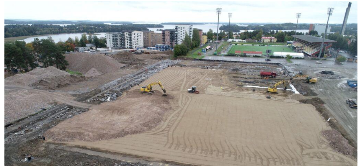
Mölymäen rakennustyömaa Kuopiossa, kun alue oli vielä rakenteilla. Murrosmedia 2025.
